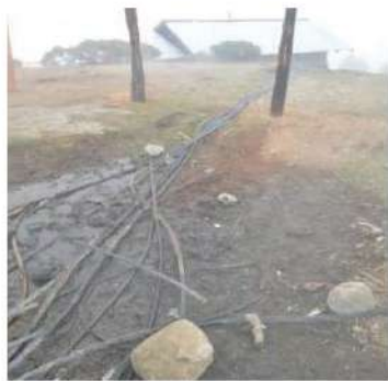
Figura 5.5. Mangueras secundarias mediante las cuales es llevada el agua hacia los hogares (localidad de Potrero Nuevo, La Perla). Fotografía: Víctor Soto
